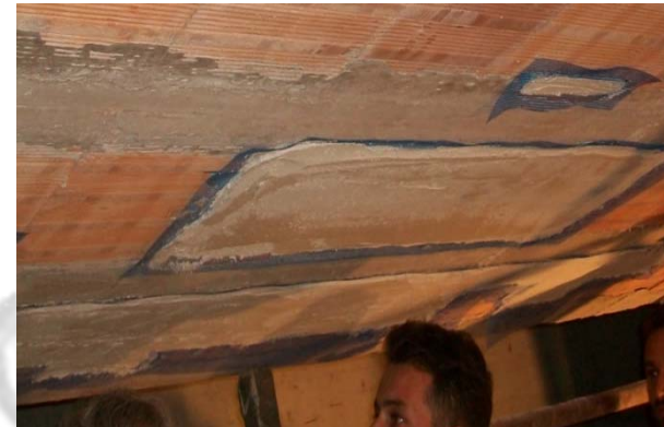
Rete in fibra di vetro + Malta fibrorinforzata a presa rapida per strato di livellamento
