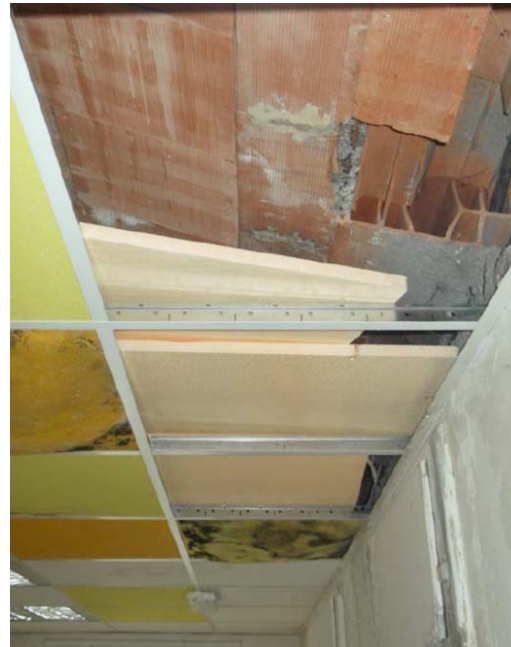
PIGNATTA DI LATERIZIO DI UN SOLAIO SFONDELLATA
