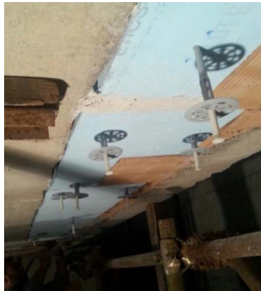
Ancoraggio meccanico mediante tasselli
